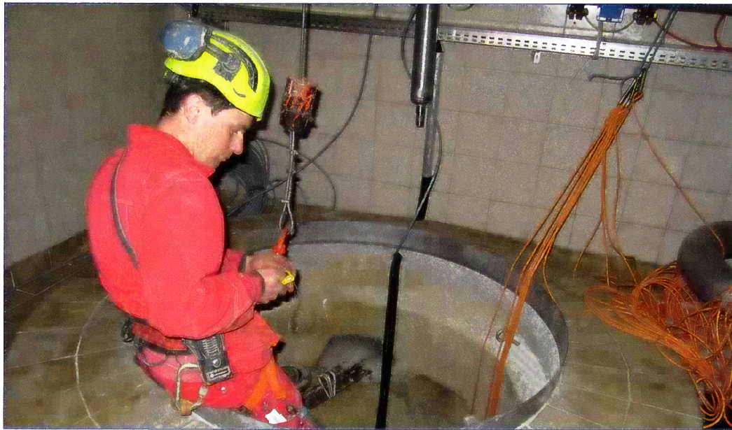
Eine große Herausforderung war die Sanierung vom Gurtenbrunnen Lamprechtshausen, der im Jahr 2016 durch Trockenheit ausgefallen ist.
